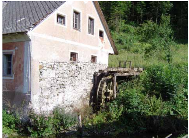
Mlin v Dolu počasi obnavljajo
