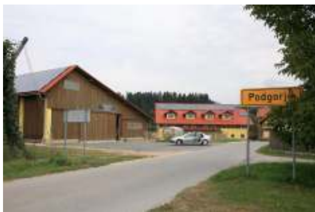
MFE Strmčnik 49,57 kWp
