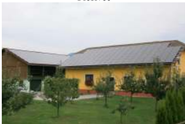
MFE Cokan 36,36 kWp
